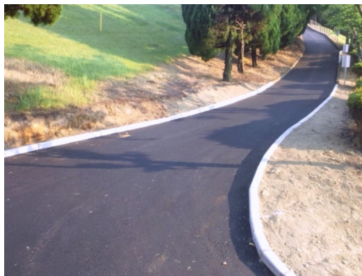
アスファルト舗装工事
