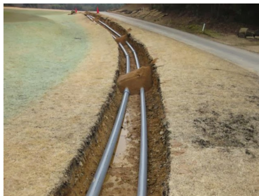
散水用配管工事
