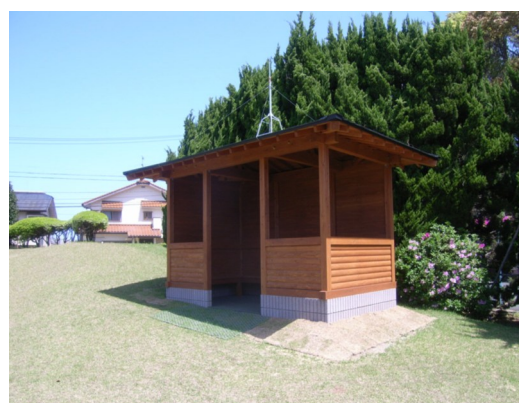
避雷小屋設置工事
