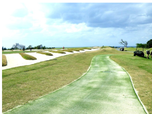
カート道人工芝工事
