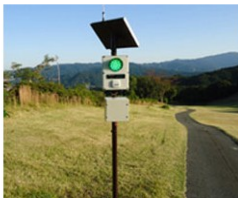
打ち込み防止信号機設置工事
