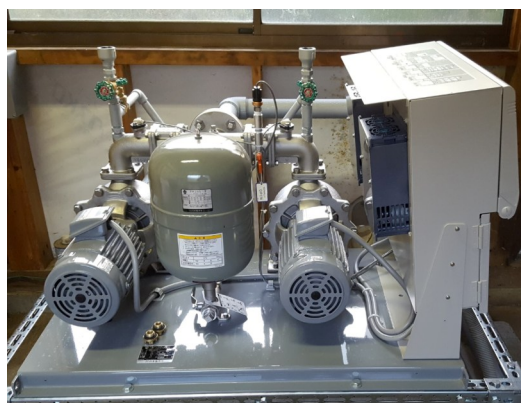
散水ポンプ交換工事
