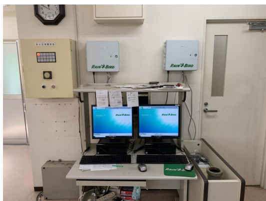
散水制御システム工事
