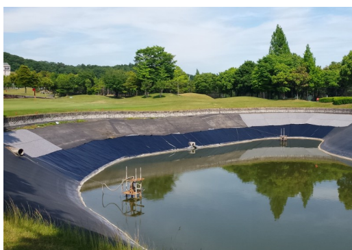
遮水シート工事
