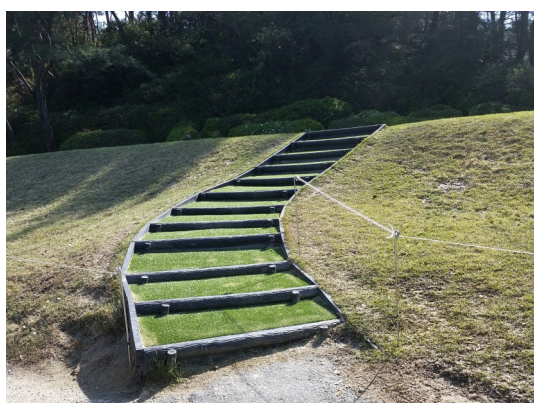
擬木階段設置工事
