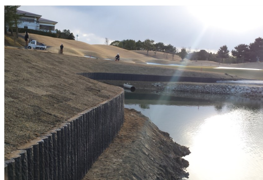
護岸改修工事
