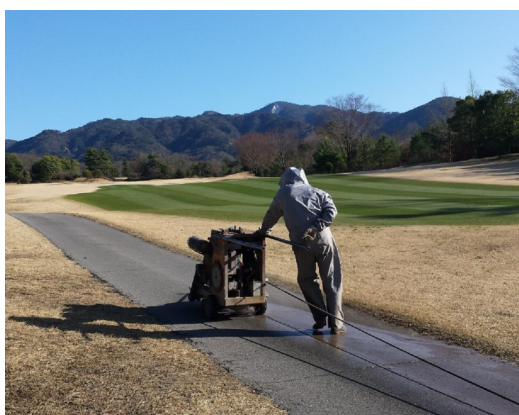
電磁誘導ケーブル入線工事
