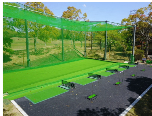
練習場造成工事
