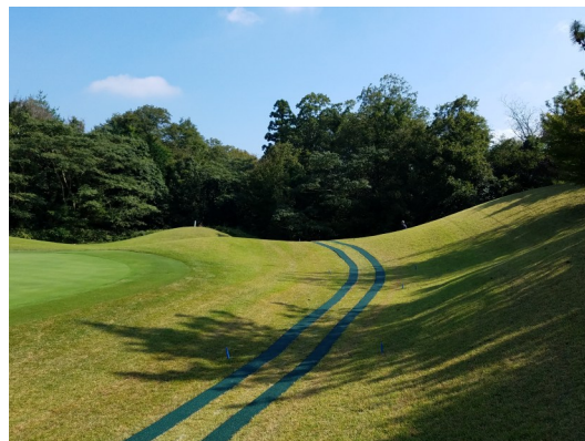
カートレール工事
