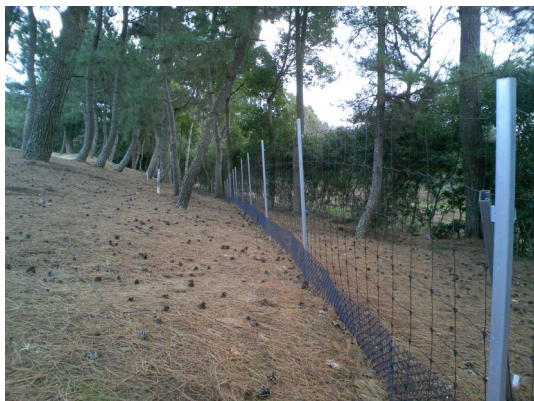
獣害防護柵設置工事
