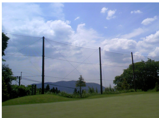
防球ネット工事
