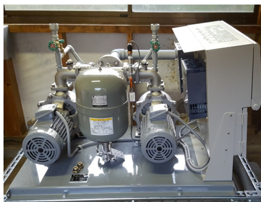
散水ポンプ交換工事
