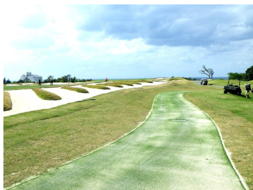
カート道人工芝工事
