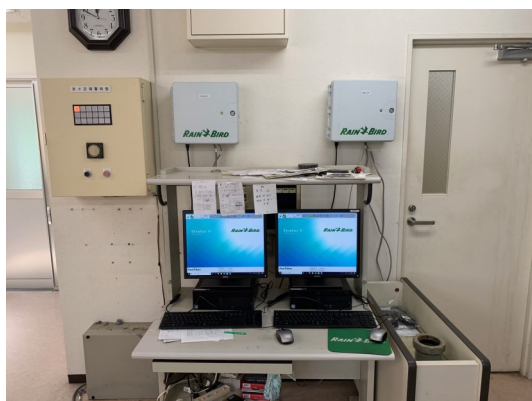
散水制御システム工事
