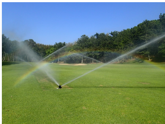
スプリンクラー設置工事
