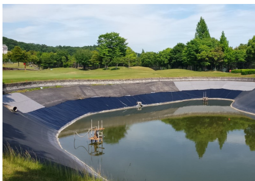
遮水シート工事
