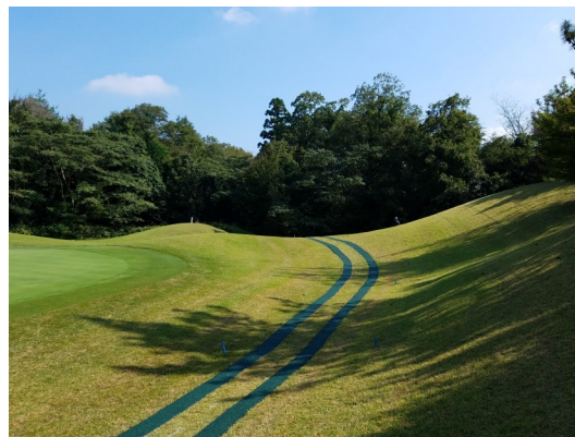
カートレール工事
