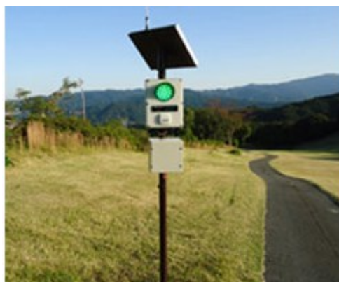
打ち込み防止信号機設置工事
