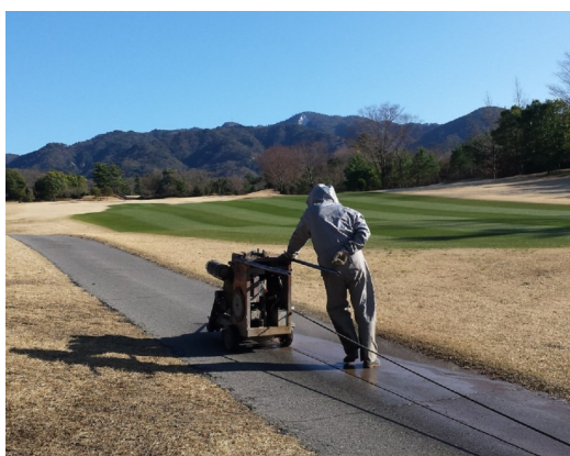
電磁誘導ケーブル入線工事
