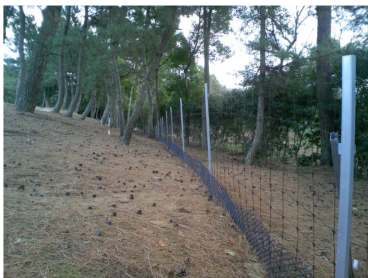
獣害防護柵設置工事
