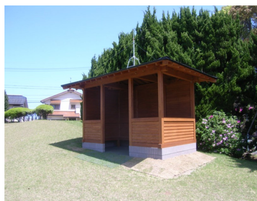
避雷小屋設置工事
