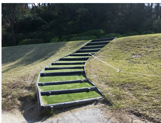
擬木階段設置工事
