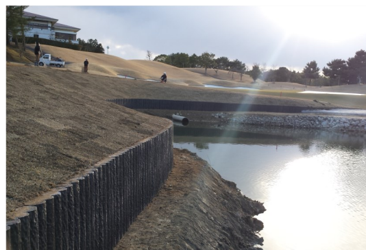
護岸改修工事
