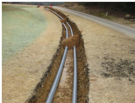
散水用配管工事
