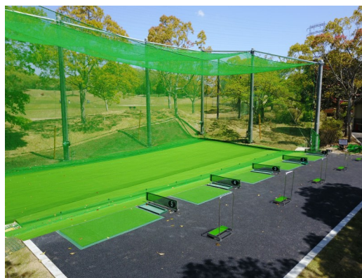
練習場造成工事
