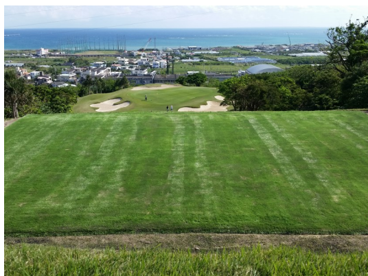
ティーグラウンド人工芝工事
