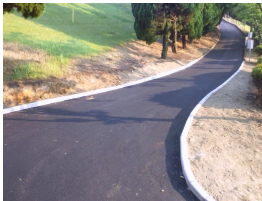
アスファルト舗装工事
