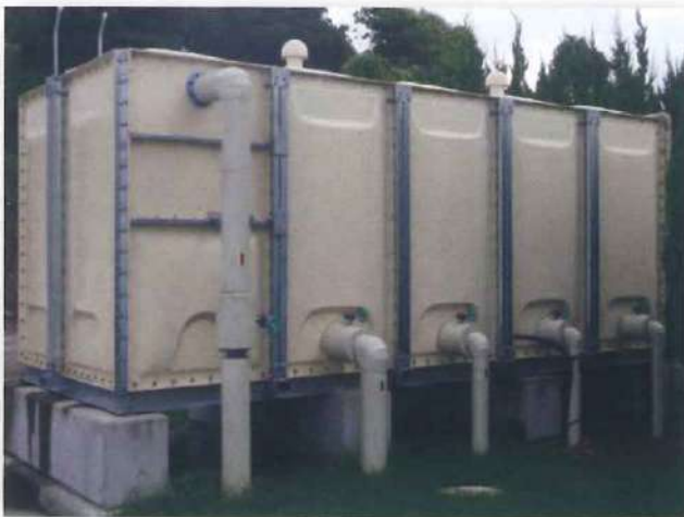
Works.03 | 貯水槽タンク設置工事
