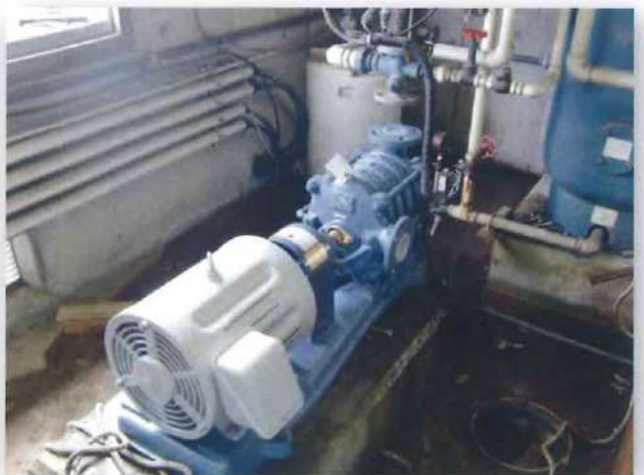
Works.04 | ポンプ入替工事
