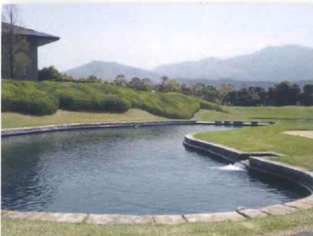
Works.05 | 池シート工事
