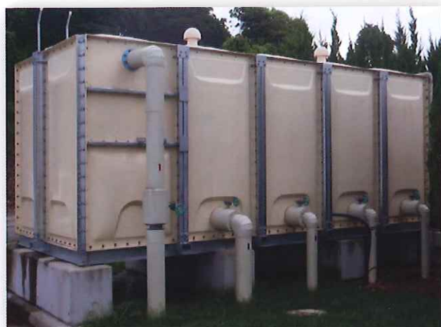
貯水槽タンク設置工事
