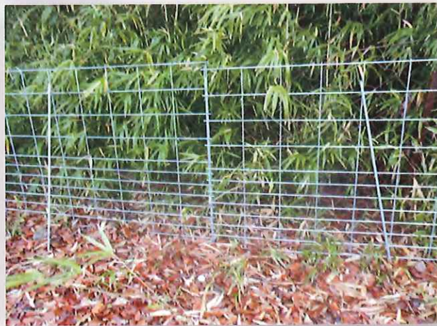
猪用防護柵設置工事
