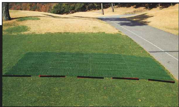
8. シグマ・マット設置完成!
