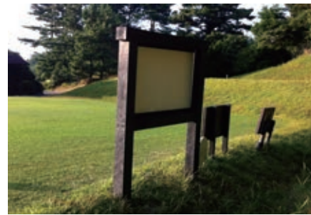
施工写真 [後方]
