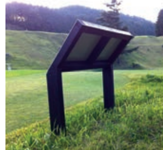
施工写真 [後方]
